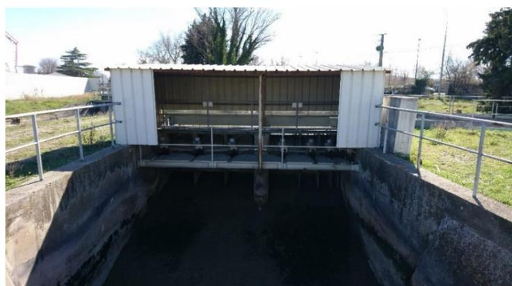
Figure 32 : Prises d'eau et modules à masque du canal Crillon au lieu-dit « Point Triple »
