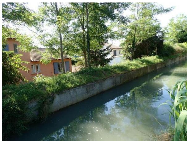
Les secteurs où **les berges des canaux sont sous-cavées**, voire où l'on observe des sapements de berges, sont également nombreux : *cf. état des lieux des canaux*. Ces détériorations ont déjà nécessité d'importants travaux de confortement (cuvelage ou enrochement ponctuel).
